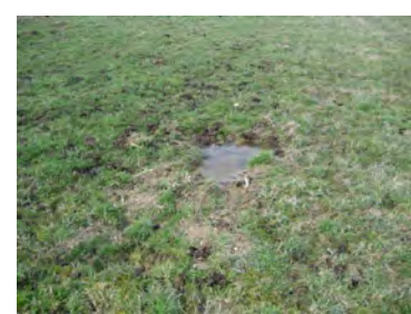
tiefer überwinterter Aufbruch
